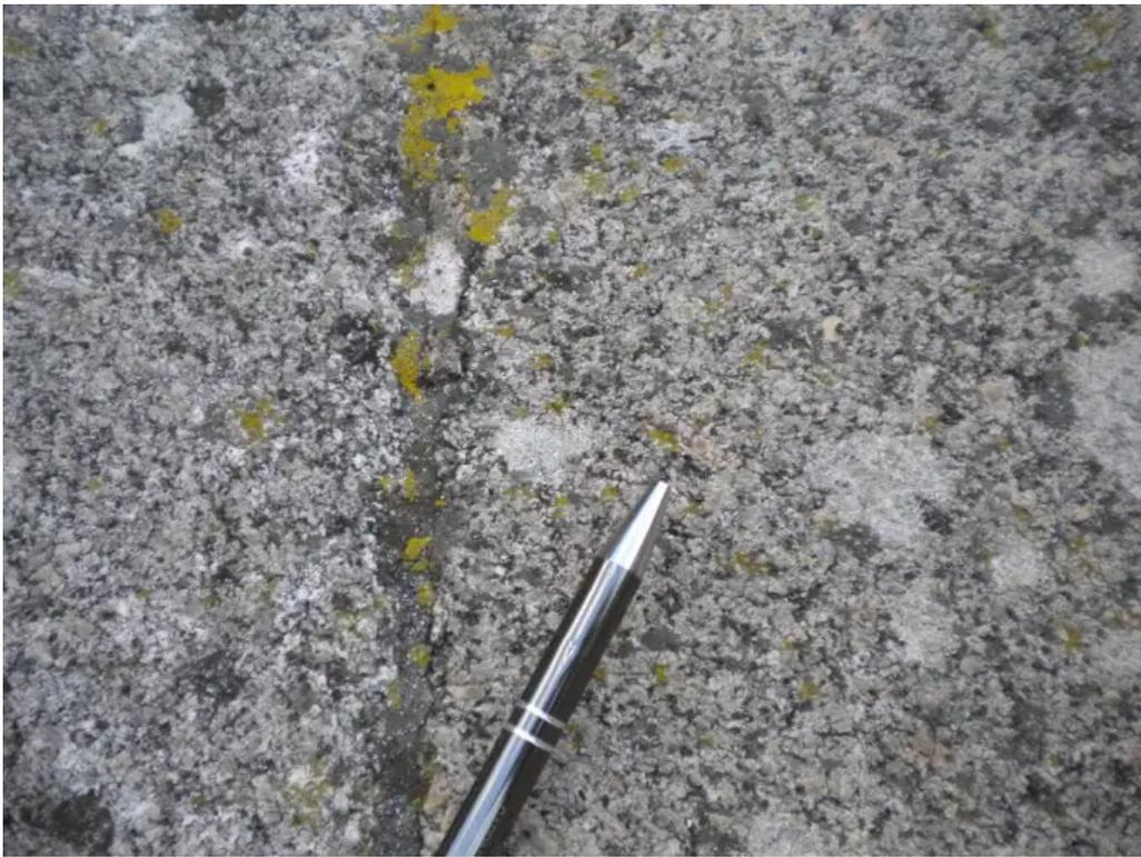
*Vaugnerit ist ein dunkles Granitgestein, das hauptsächlich in Zamora und Salamanca verwendet wurde. Dieses Bild zeigt das Detail des in der Kathedrale von Salamanca verwendeten Vaugnerits (eigenes Bild).*
