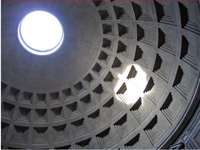
Auch für die gewaltige Dachkuppel des Pantheons verwendeten die Römer Beton. Foto: Sascha Ruhland / pixelio.de
